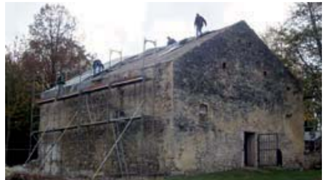
Der Weismannstadel während der Notsicherung
