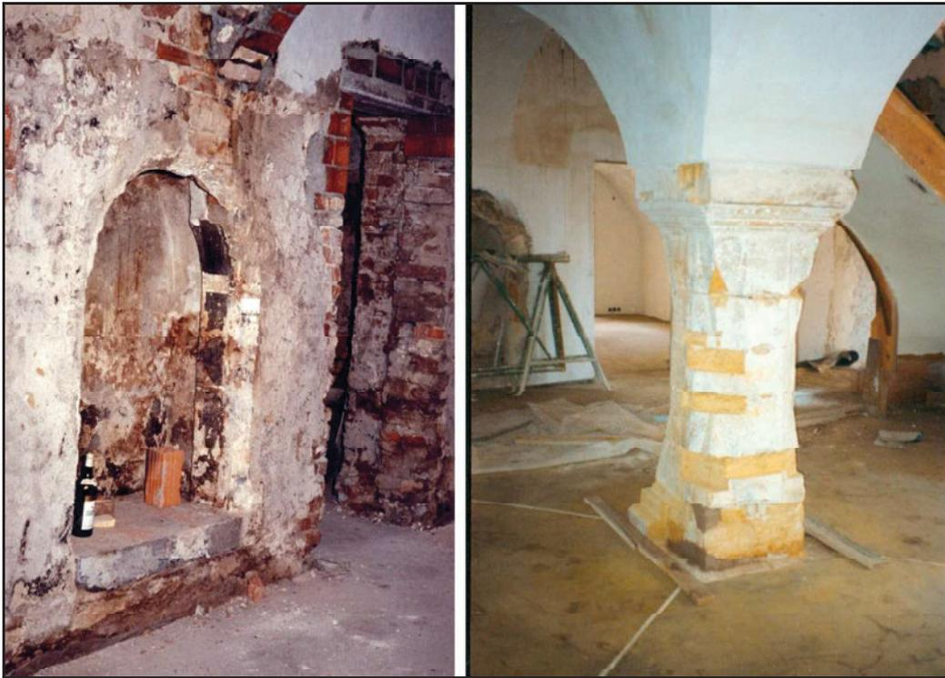
*Das Erdgeschoss mit Grotte und der Säule, die rund  $\frac{1}{3}$  der Gebäudelast trägt.*
