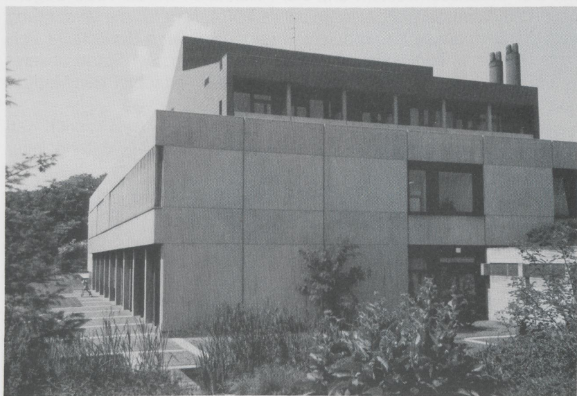
Ansicht des 1972/74 errichteten Neubaus von Südosten
