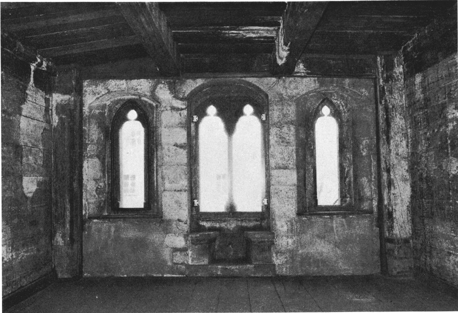
Abb. 7 Die Kemenate mit freigelegten Bohlenwänden und ergänzter Fensterarkade (1974)
