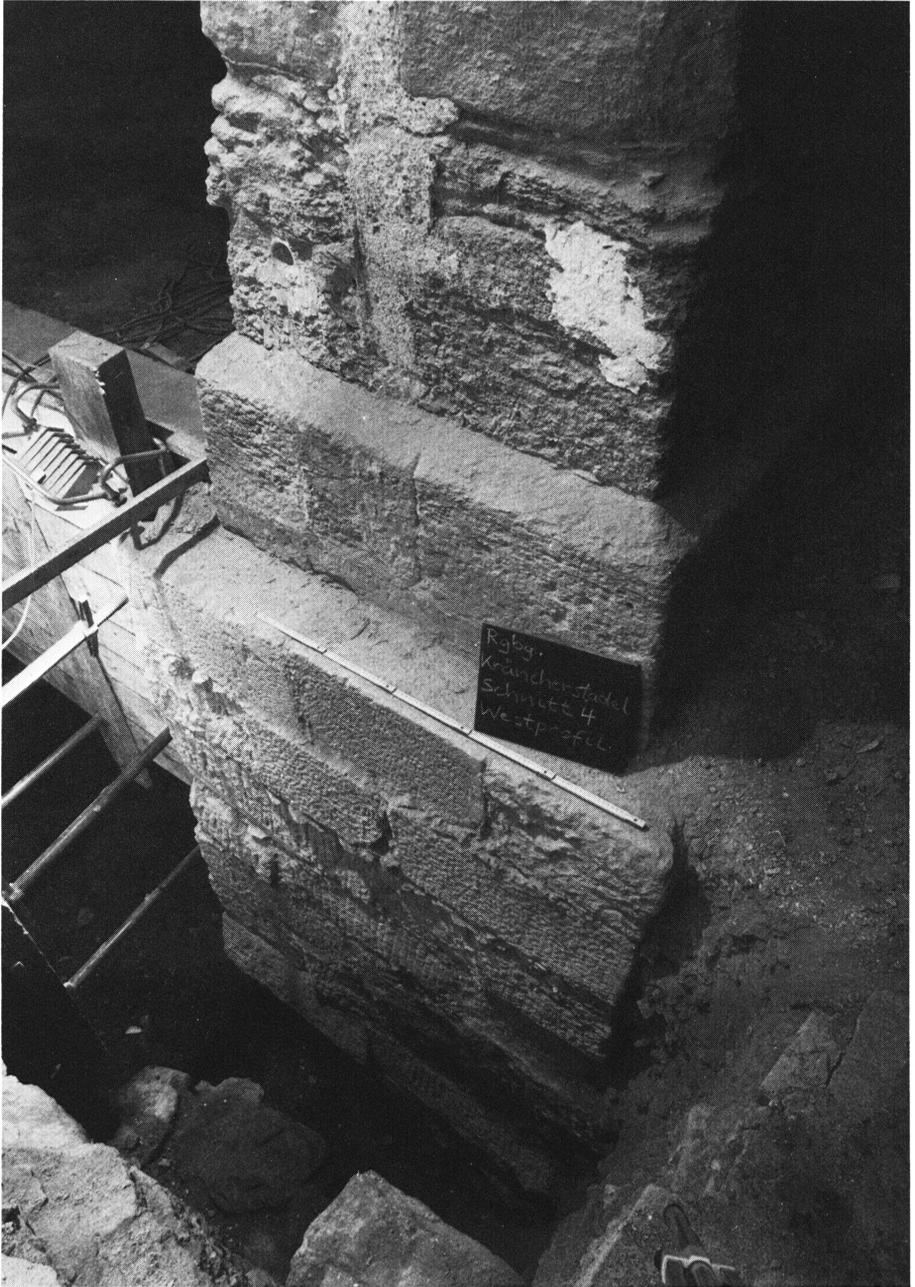
Abb. 3: Oberer Fundamentbereich des nachträglich eingesetzten Steinfeilers A.
