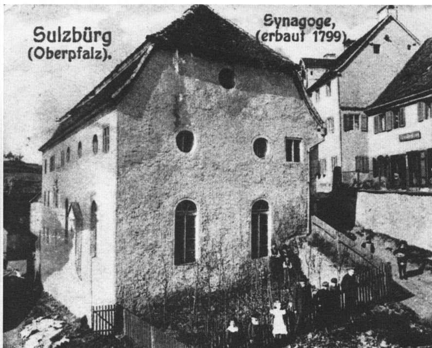
Abb. 1: „Schul“, auf eigene Kosten von dem Sulzbürger Grundstückshändler und Militärlieferanten Hirsch Nathan Neuhaus erbaut. Christliche Sulzbürger hatten kostenlos Materialfuhrten besorgt (Postkarte von 1911).
