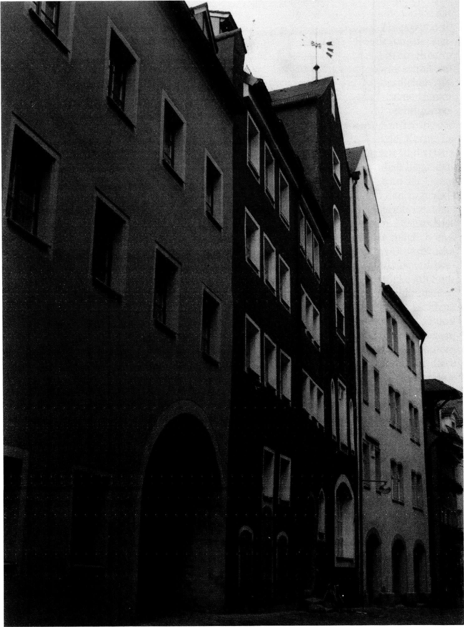
Abb.2: Regensburg, Stadt, Opf. Vor der Grieb 1, 3 u. 5. Fassaden zur Gasse mit den zwei Haustürmen nebeneinander.
