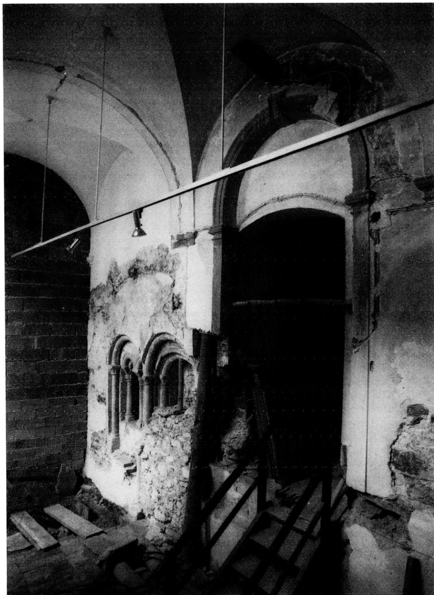
Abb. 1a: Füssen, Kreuzgang des ehem. St.Mang-Klosters, Herkommer-Bau des 18. Jahrhunderts, mit Wölbung und Portal, tief ausgeschachtet. Die dabei entfernten profilierten Basen des Portals sind zu ergänzen. Links freigelegt zwei Bögen einer alten, ursprünglich 3-bogigen Portalarchitektur.
