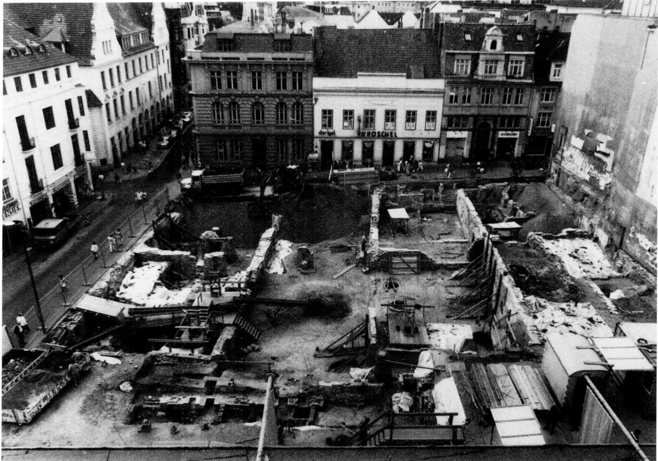
Lübeck, Grabung Schraggen 1992: Durch Großbauvorhaben ausgelöste grundstücksübergreifende Rettungsgrabungen lassen die aus der Aufteilung von Großgrundstücken entstandenen, langen, schmalen und dicht bebauten Parzellen erkennen, die typisch für die Bebauungsstruktur der führenden Städte im spätmittelalterlichen Europa sind.
