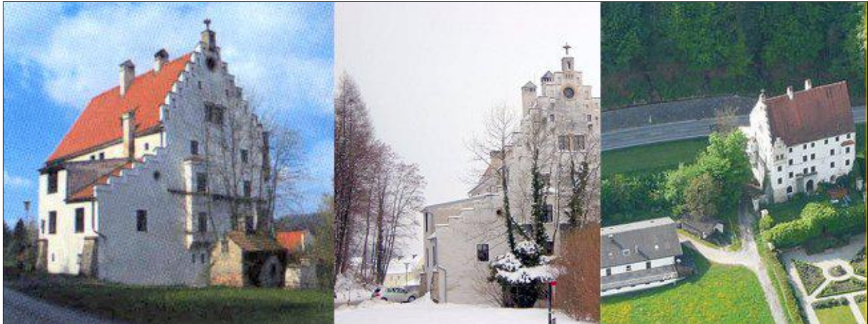
Abb. 84: Links historische Farbaufnahme (um 1960) mit kleinem Beigebäude im Vordergrund rechts. Die Aufnahmen in der Mitte und rechts zeigen die heutige Situation, das verfallbedrohte Beigebäude ist unter dem Blätterwald eines Rankgewächses nahezu vollständig verschwunden.
