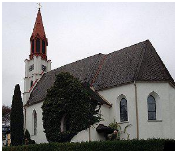
Abb. 101: Die historische Kirche St. Martin in Attersee, deren Ursprünge in die Karolingerzeit zurückreichen. Der neugotische Turm wurde erst 1854 errichtet.
