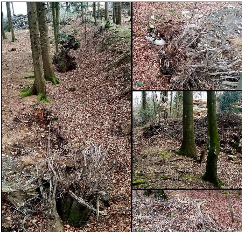
Der obere Wallgraben ist mit Wurzelstöcken, Astwerk und anderen Bio-Unrat zugemüllt.
