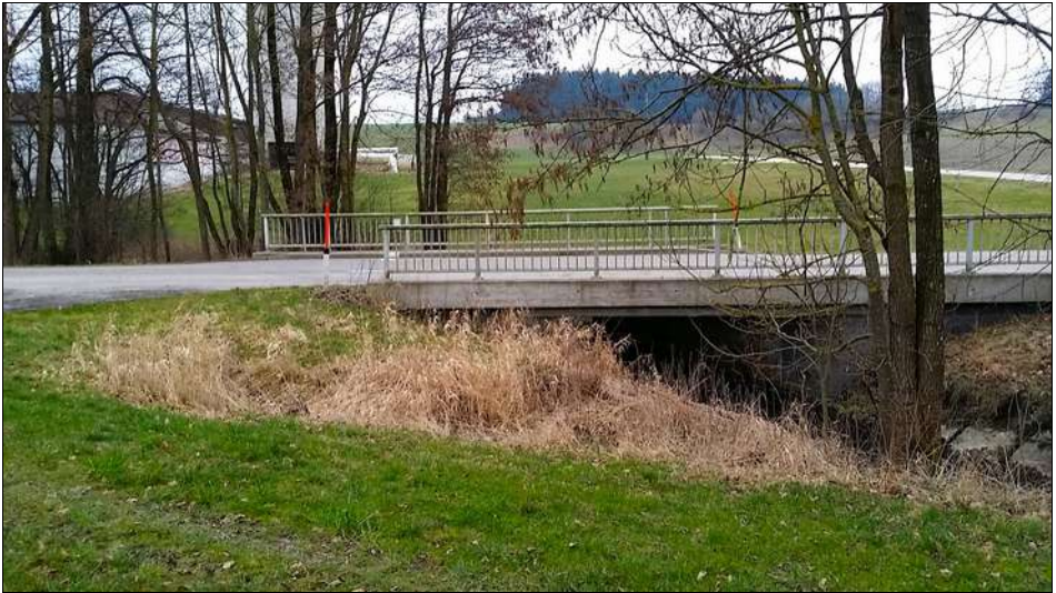
Die Brücke über die Osternach ist heute betoniert.
