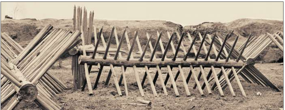
Spanische Reiter als mobiles Sperrwerk.
