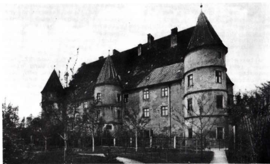
Vohenstrauß, Sonderaufstieg, erbaut vom Pfalzgrafen Sinding 1586-1593
