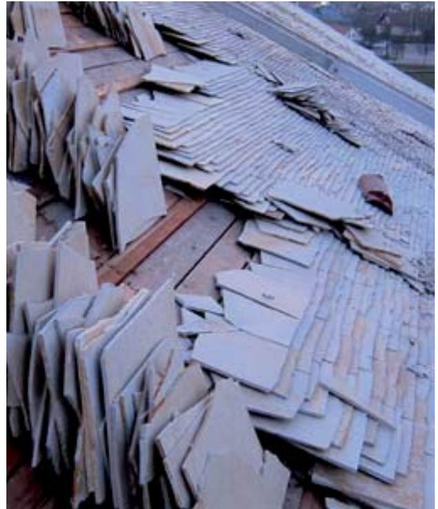
werden die Kalkplatten übereinander gelegt, die nächste Lage immer ein paar Zentimeter gegenüber der darunter liegenden zurücktretend. So ergibt sich eine Stärke der Dachhaut von etwa 8 bis 15 cm. Zur Gewährleistung des Tagwasserablaufs ist es wichtig, dass die Platten nach außen immer ein Gefälle von ca. 15° aufweisen. Auf dem First überragten früher größere Platten der Wetterseite die andere Seite. Sie waren
