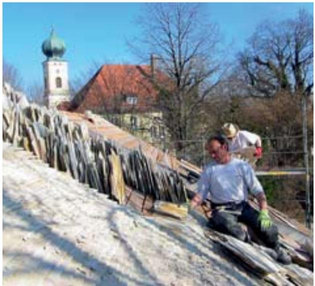
Die Traufplatten wurden mit Blechhaften gegen Abrutschen gesichert. Am First haben wir zunächst die Legschieferplatten angedeckt und die letzten zwei Steinreihen mit Steinkleber beidseitig angeklebt. Dann wurden rote Patentlüfterfirstziegel mit grauem Dachdeckermörtel eingebaut und mit Firstklammern am Vorkopf angeschraubt.
