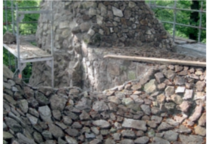
Abb. 28: Die neuen Mauerkronen ohne Verfugung (Oktober 2006).
