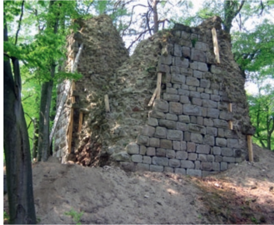
Abb. 20: Fotografie der Südseite mit Stützbalken (Mai 2006).
