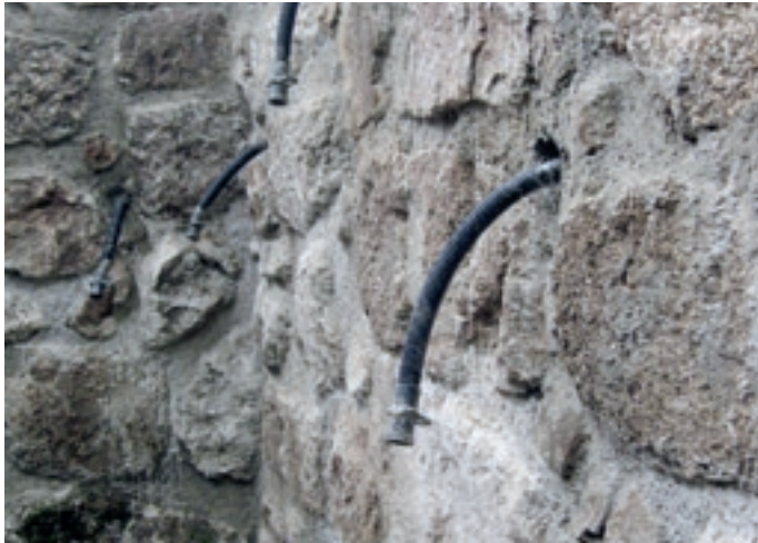
Abb. 23: Großflächige Hinterfüllung durch Verwendung von Packern (Oktober 2006).
