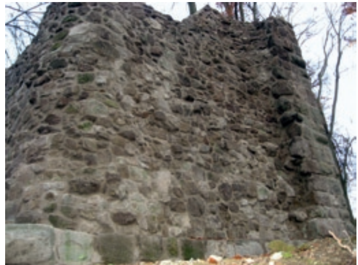
Abb. 30: Die wiederhergestellte Nordseite (Oktober 2006).
