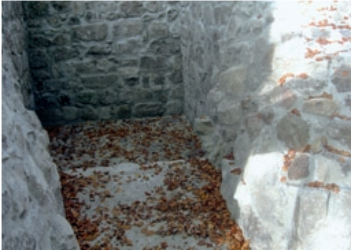
Abb. 27: Der wiederhergestellte Innenraum des Bergfrieds (Oktober 2006).
