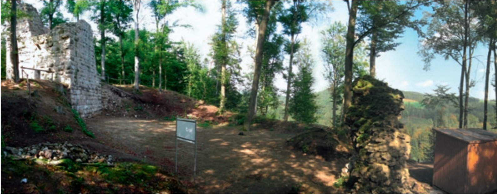
Abb. 35: Panoramaaufnahme von Turm, Innenhof, Torbogen und Mehrzweckbude (September 2007).
