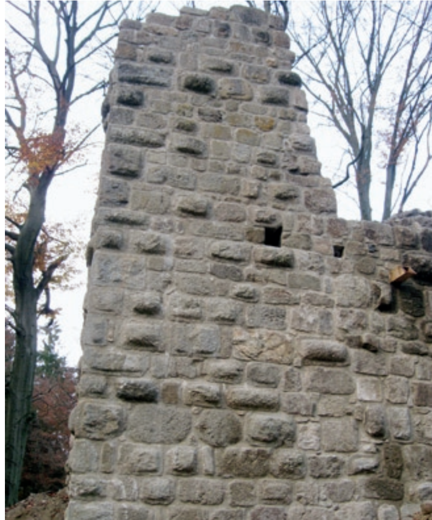
Abb. 32: Die Nordwestecke. Am rechten mittleren Bildrand ist der eichenholzverzierte Abfluss aus dem Innenraum zu sehen (Oktober 2006).
