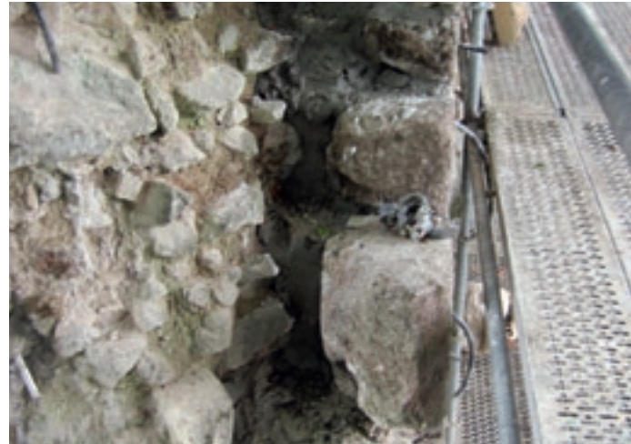
Abb. 24: Die Lücke zwischen den Mauerschichten wird gefüllt (August 2006).
