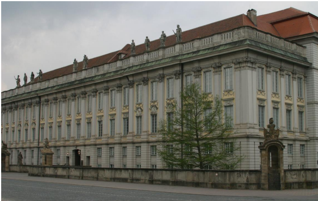
Fig. 8: A fachada sudeste da residência do marquês de Ansbach, que foi revestida com vidraças de Irlbrunn. (Foto de 1961). 60
