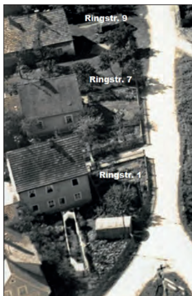
Abb. 6: Häuser der Ringstraße 1, 7 und 9 (Luftaufnahme von 1936).
