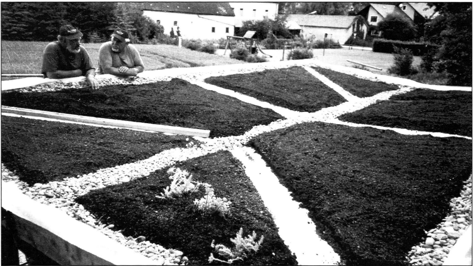
Das begrünte Dach des Andachtsraumes
