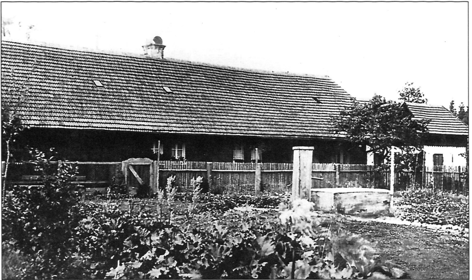
Das Forsthaus Diensthütte Neudorf mit Nebengebäude vor dem Abbruch im Jahre 1951
