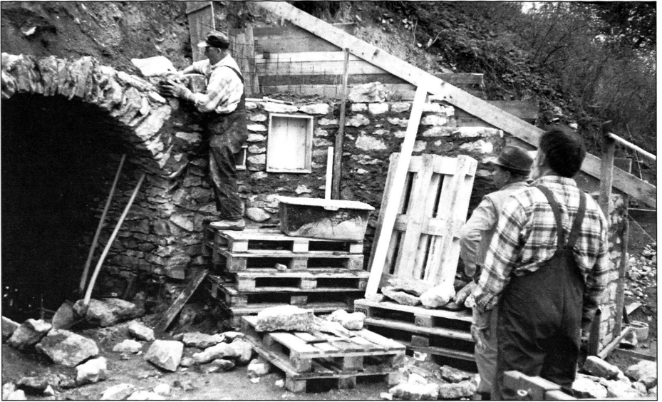
Baustelle (v.l. Hans Straubinger, Albert Stiegler, Hans Auburger)
