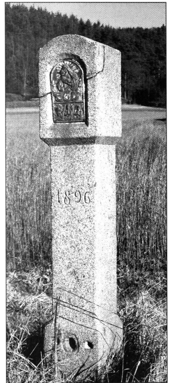
Das Flurdenkmal vor der Instandsetzung
