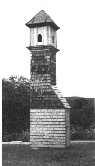
*Abb. 2 Schönthan (Stadt Oberviechtach). Einer der schönsten Glockentürme mit Schindel-Verschalung. Die Eingangstür ist vorgezogen und mit einem Pultdach überdeckt. Der Schallock-Absatz ist mit einem Sims abgetrennt. Das Pyramidendach aus Blech trägt die Wetterfahne. Der Glockenturm wurde 1987 liebevoll restauriert.*
