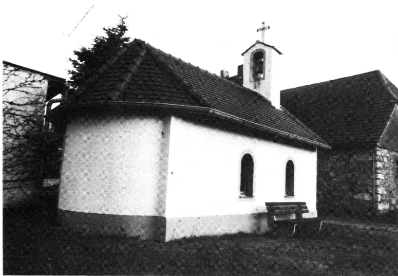
Pestkapelle Prünthal Ansicht von Nordwesten
