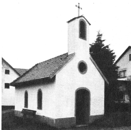
Pestkapelle Prünthal Ansicht von Nordwesten
