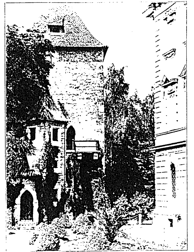
Emmeramerthor vor Erbauung der Verbindungsbrücke.
