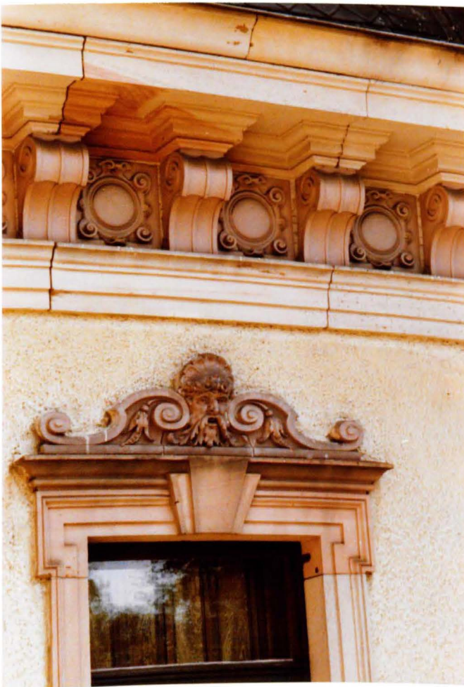
Fensterverdachung mit Fratze, zweites Obergeschoß
