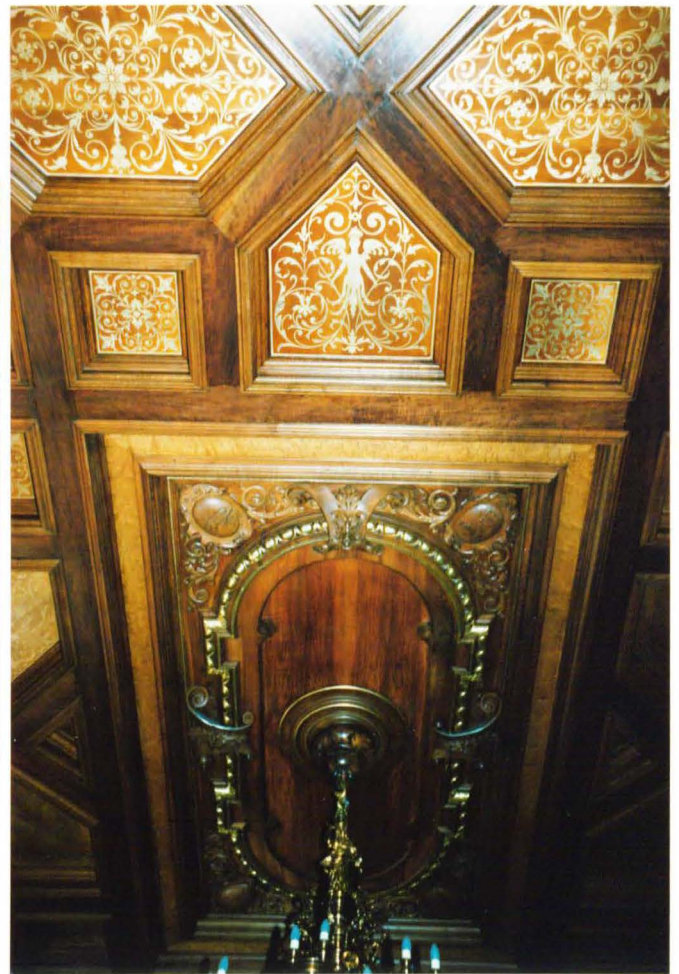
b) Blick auf die in Nußbaum mit Eichenprofil- leisten und Ahornfüllungen gearbeitete und mit Goldornament bemalte Holzkassettendecke im Empfangsalon. W.B. 1987.
