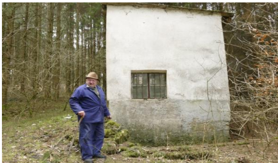
Herr Weidinger, ehem. Wasserwart, mit dem Pumpenhaus
