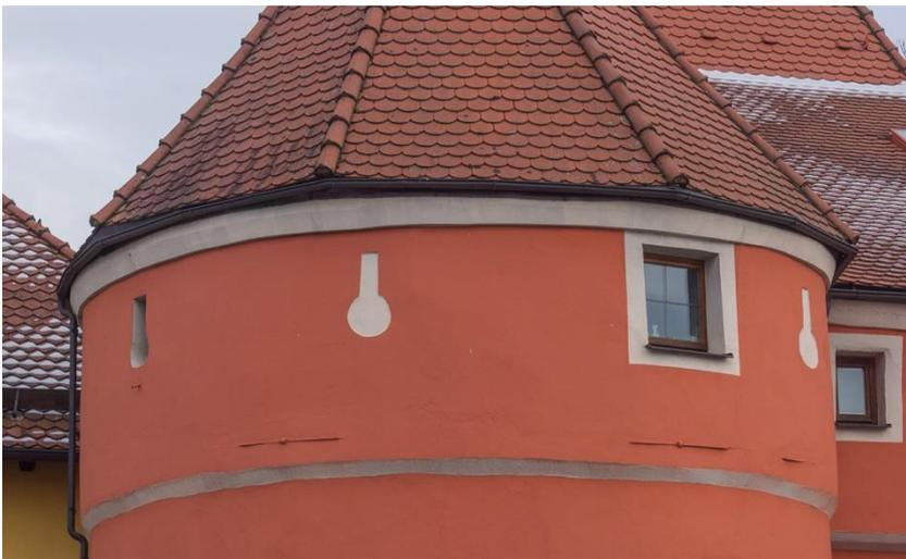
Abbildung 4: Offene bzw. vermauerte Schlüsselscharten in der Frontseite des linken Rundturms des Biertors/ehemals Burgtors mit homogen wirkendem Mauerwerk
