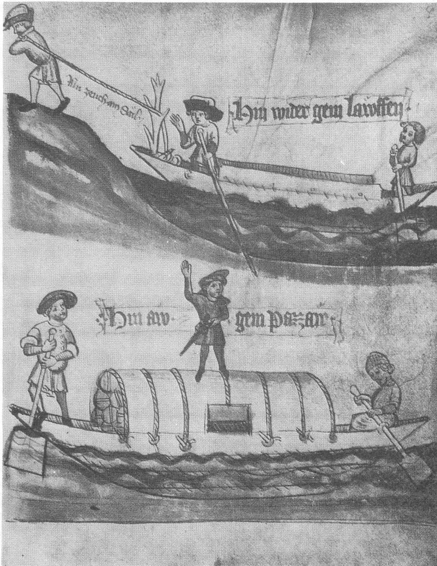
Abb. 8: Miniatur aus dem Zechbuch der Passauer Schifflente, Anfang 15. Jh. (Oberösterreichisches Schifffahrtsmuseum Schloß Greinburg). Aus der Darstellung in der oberen Bildhälfte wird gut erkennbar, wie sich der Storz (Führungsholz für das Zugseil) aus einem Stamm mit stehengelassenen Astteilen entwickelt hat. Klar zu sehen sind auch die Böngel an der Schiffswand.
