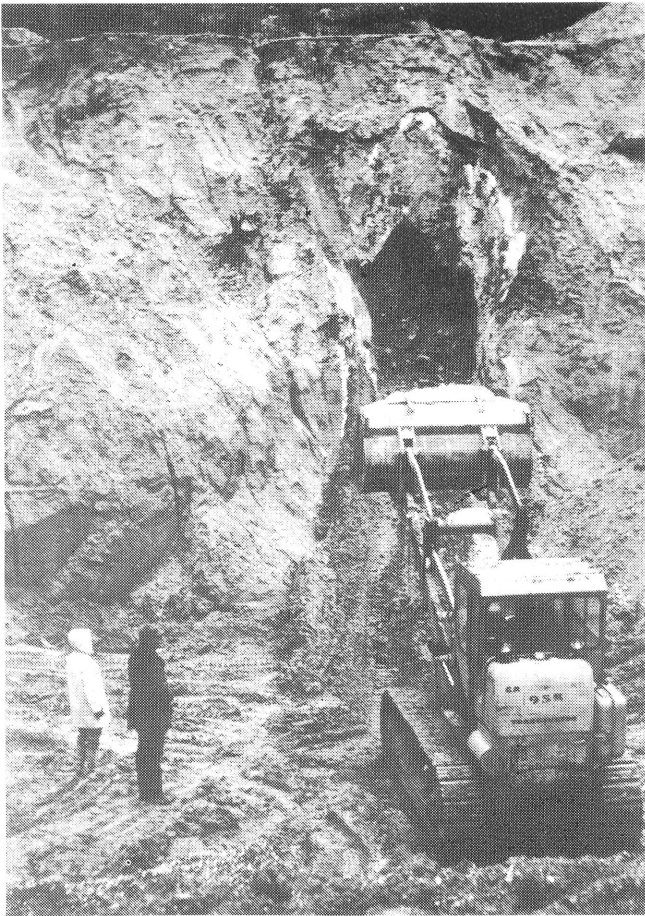
Abb. 13: Schurf G im Oktober 1974. In einer vertikalen rillenförmigen Eintiefung in den weißen Kelheimer Kalken sind die (dunklen) Grünen Tonigen Sande besonders mächtig. Kalk und Impaktitische Bildungen fallen fast senkrecht (85°) in Richtung auf den Beschauer zur Grubenmitte ein. Die Distanz Grubensohle-Oberkante beträgt rund 11 Meter.
