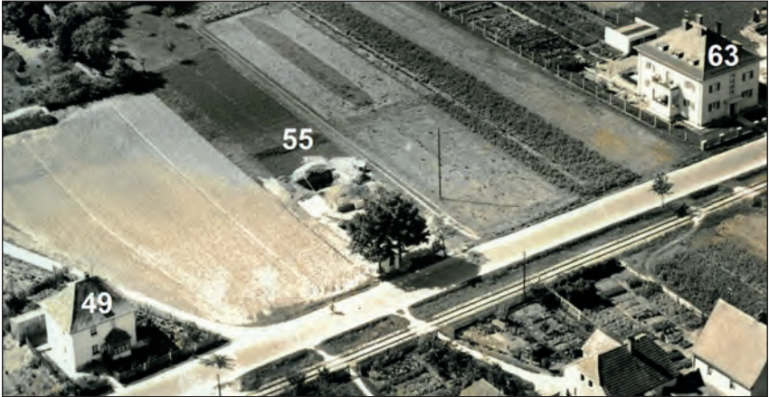
Abb. 3: Hauptstraße 49 und 63, hinter der Hirmer-Kapelle befindet sich bereits die Baugru- be für das Haus Hauptstraße 55 (Luftaufnahme von 1936)
