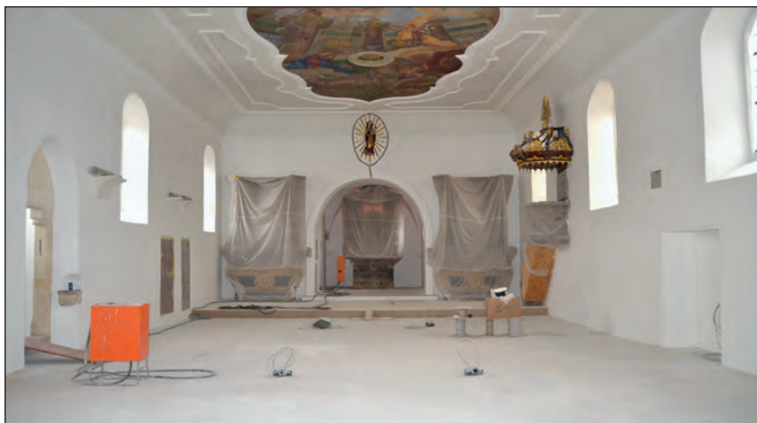
Abb.3: Pfarrkirche Mariä Verkündigung wird saniert.
