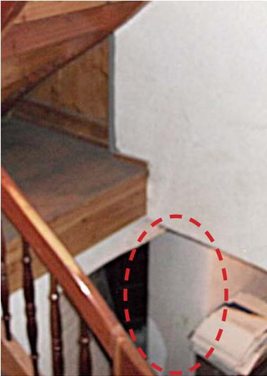
Im unteren Bildabschnitt ist die alte Türöffnung für die hintere Haustüre zu sehen. Die Wandstärke lässt auf die hintere Außenmauer aus Bruchsteinen schließen. Die Bruchsteinmauer muss auf die Anfänge des Baubestandes zurückgehen.
