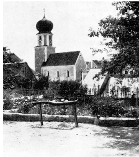
Fig. 112. Klapfenberg. Nordansicht der Pfarrkirche.
