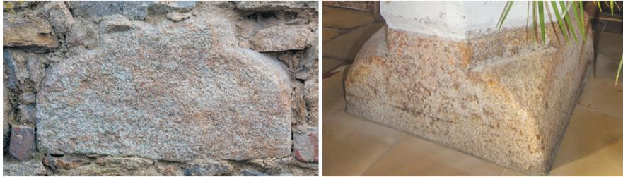
Abb. 30: Links: Wiederverbautes Bauteil im Bereich des ehemaligen Torbogens mit Profilierung
