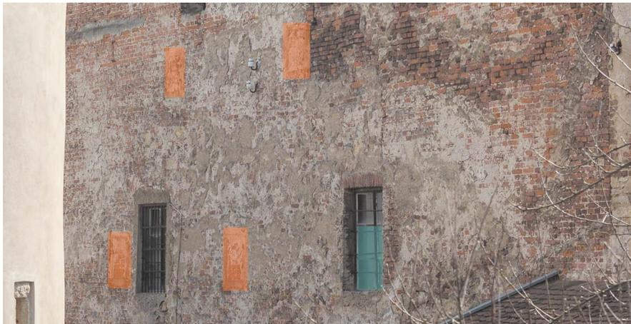
Abb. 41: Ostfassade des ehemaligen Eiskellers/späteren Fass-Lagerkellers der Brauerei mit vier zugesetzten Fenstern (orange eingefärbt) (orientiert man sich an den Abständen der vorhandenen Fenster, so ist anzunehmen, dass ein fünftes Fenster bei den Umbaumaßnahmen 1894 vergrößert wurde (blau eingefärbt))
