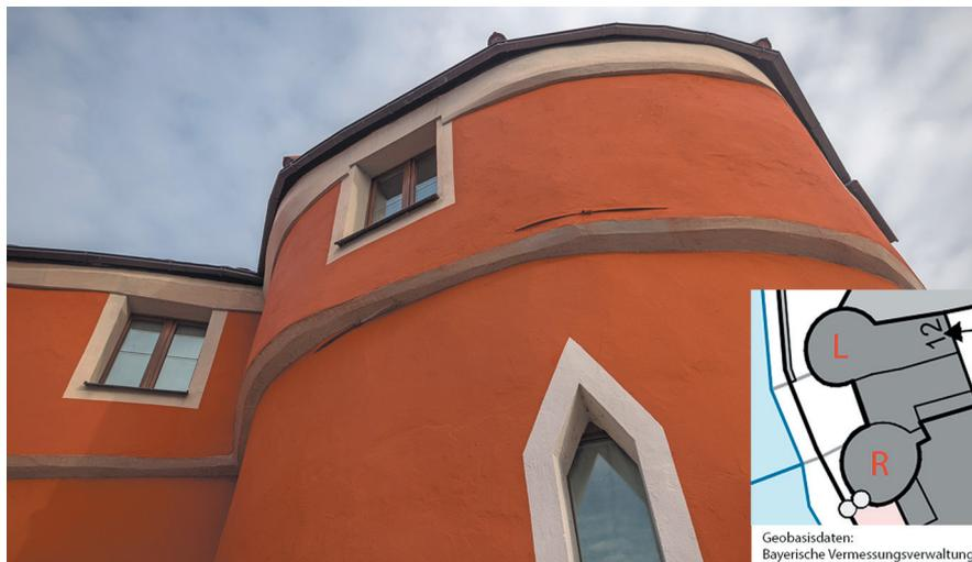
Abb. 3: Hintergrund: Unteransicht der Frontseite des rechten Rundturms des Biertors/ehemals Burgtors mit gequetschtem Mauerwerk
