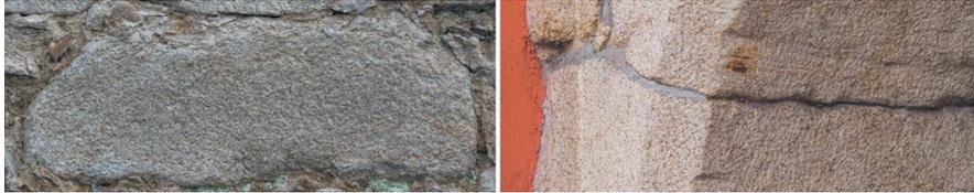
Abb. 16: Links: Wiederverbautes Bauteil im Bereich des ehemaligen Torbogens mit abgefaste Kanten. Rechts: Abgefaste Steine aus dem Torbogen des Biertors/ehemaligen Burgtors
