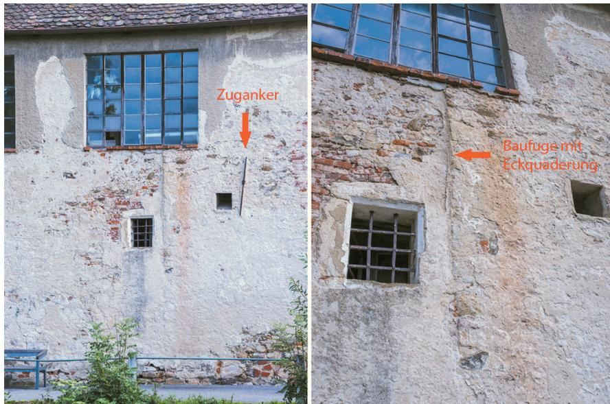
Abb. 20: Links/Rechts: Baufrage mit offensichtlicher Eckquaderung und Zuganker im mittleren Gebäudeteil des ehemaligen „Chamer Stadtschlusses“
