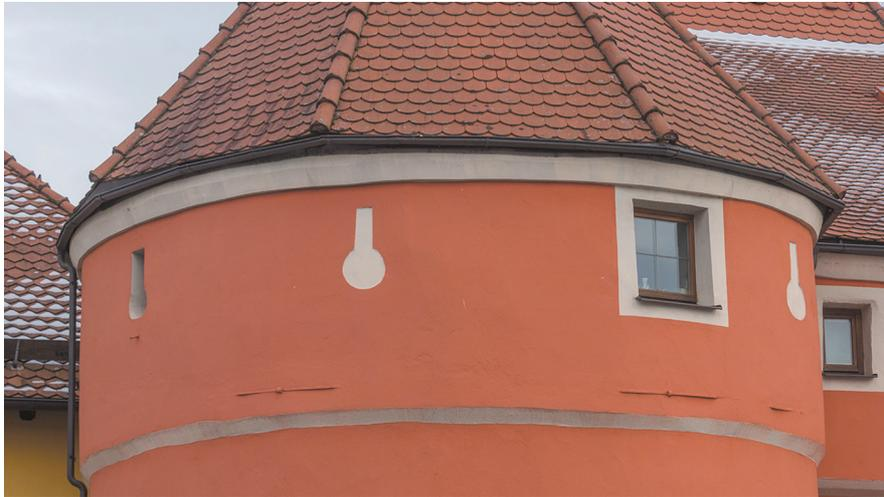
Abb. 4: Offene bzw. vermauerte Schlüsselscharten in der Frontseite des linken Rundturms des Biertors/ehemals Burgtors mit homogen wirkendem Mauerwerk
