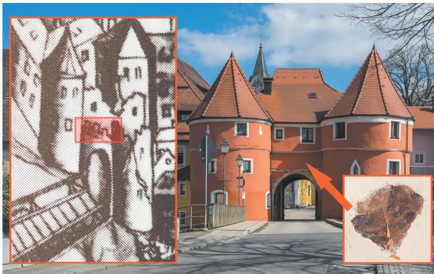
Abb. 5: Links: Detailauszug des brandgeschädigten Biertors/ehemals Burgtors mit einem sich abzeichnenden Auflager (rot markiert) aus der Federzeichnung Nr. 132a der Karten- und Plansammlung des StAAM von 1748/50. Hintergrund: Frontseite des Biertors/ehemals Burgtors (Foto: Willi Straßer, Cham auf Karten und Stichen, Bildern und Zeichnungen. Das Conterfey einer alten Stadt, Regensburg 4o. J., S. 20–21.) Rechts: Überreste eines verbauten Balkens im Durchgang des Biertors (Brandschaden)
