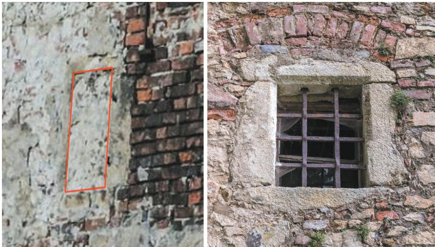
Abb. 44 Links: Detail eines zugesetzten Fensters (rot markiert) in der Ostfassade des ehemaligen Eiskellers/späteren Fass-Lagerkellers der Brauerei
