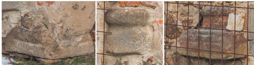
Abb. 18: Links/Mitte/Rechts: Wiederverbaute Bauteile in der Außenwand des östlichen Nebengebäudes auf dem Höchstetterareal
