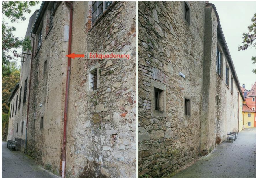
Abb. 9: Dreigeschossiges Mauerstück des ehemaligen Torturms des „Chamer Stadtschlusses“ mit akzentuierter Eckquaderung
