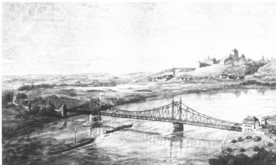
Donaubrücke zwischen Wörth und Pfatter (Länge 192 Meter)
