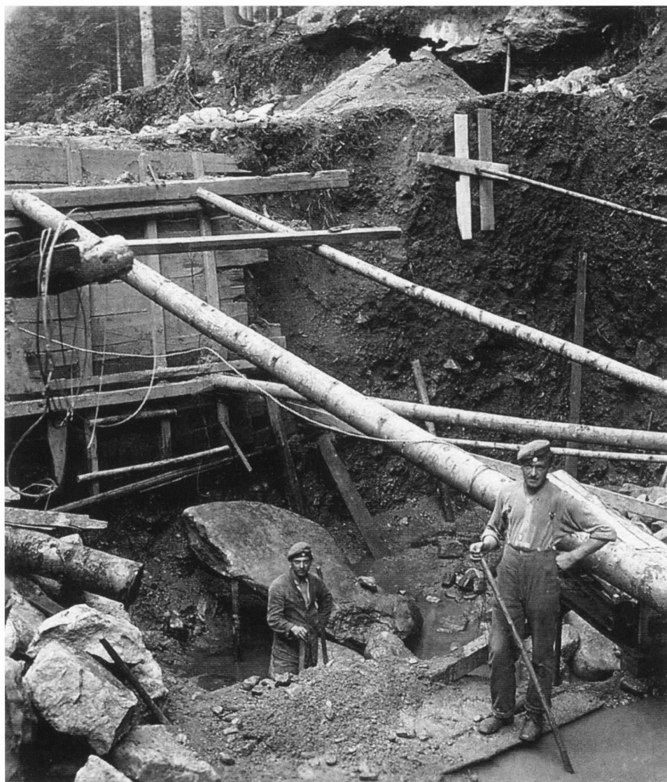
Abb. 45 Kraftwerksbau in den 20er Jahren
