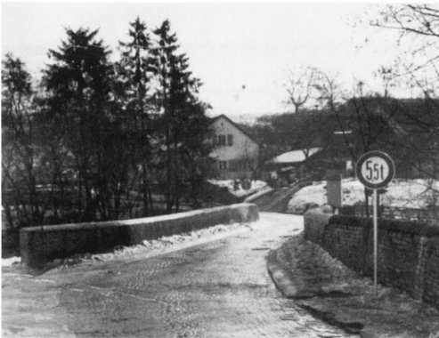
Abb. 86 Die Brücke mit einer Tragkraft bis 5,5 Tonnen
