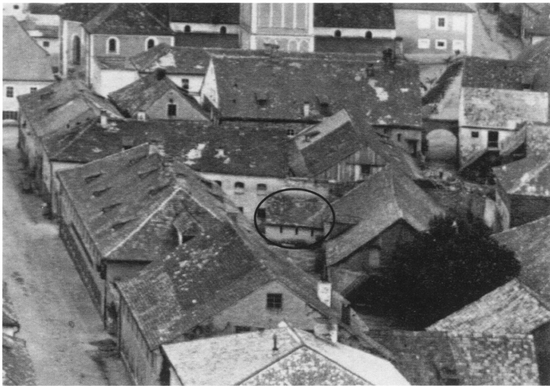
Abb. 97 Feuerwehrhaus im Hof des Dr. Schweiger Bierbräuanwesen in der Ludwigstrasse
