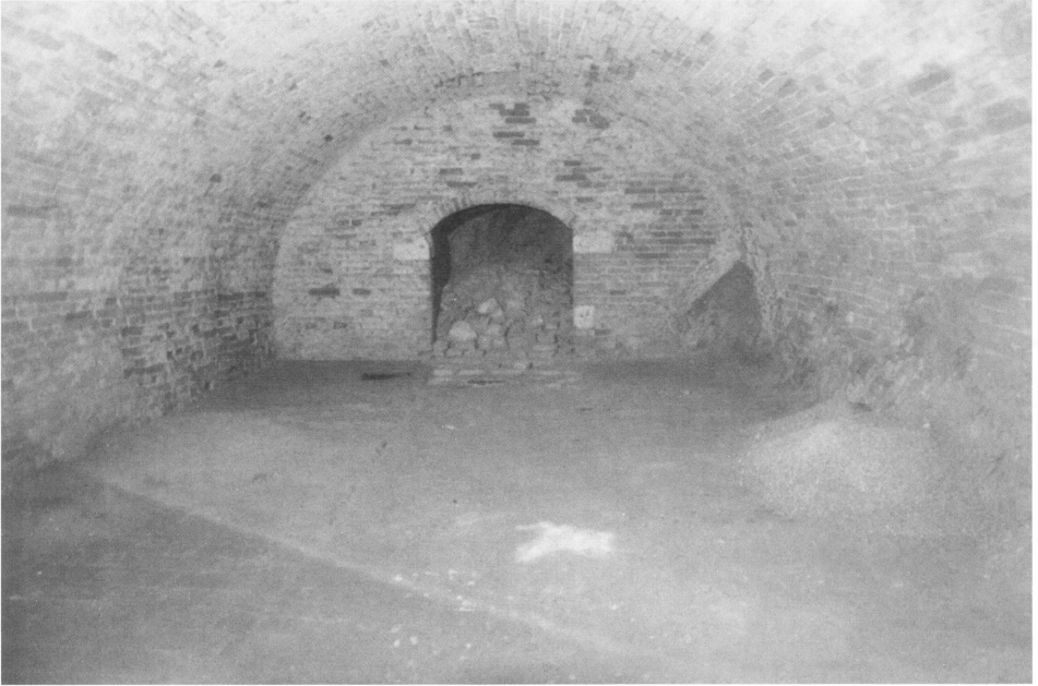
Abb. 96 Keller an der Regensburger Straße
