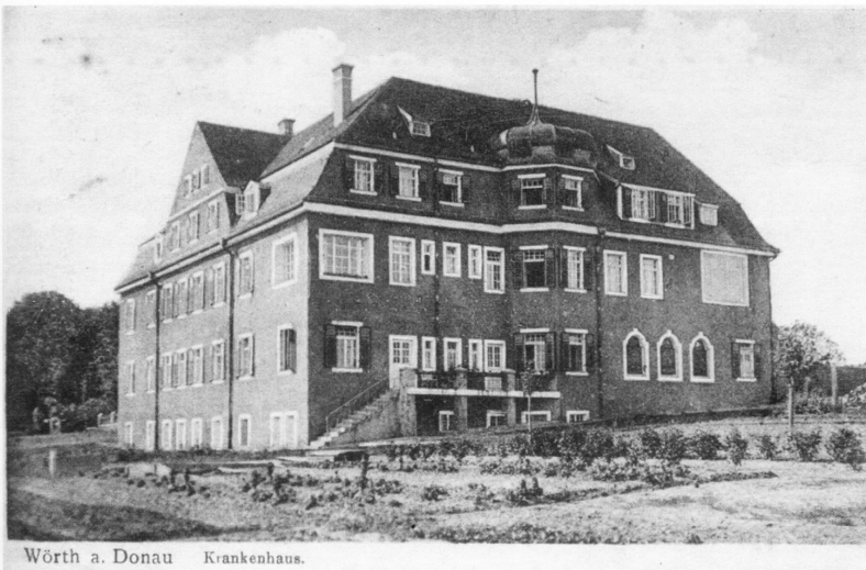
Abb. 38 Das Wörther Distriktskrankenhaus erbaut um 1920. Südost Ansicht
