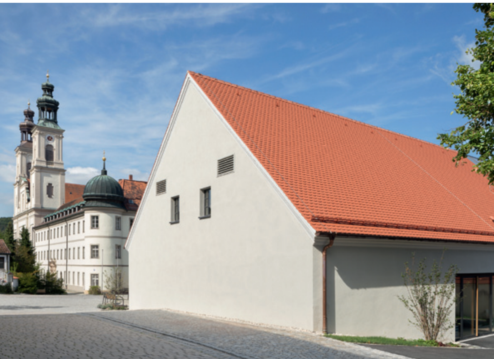
Abb. 1: Der Klosterstadel mit Blick auf Kirche und Klostergebäude
