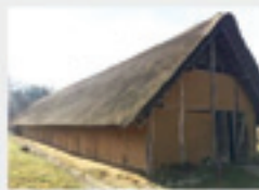
Als Beispiel für ein bandkeramisches Langhaus späterer Phasen steht die Rekonstruktion im Tierpark Straubing.
