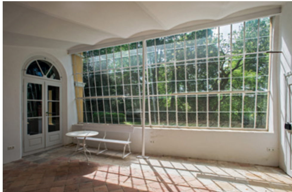
Abb. 2: Die Instandsetzung der Orangerie in Karlstein wurde nach denkmalpflegerischen Gesichtspunkten in jeder Hinsicht vorbildlich umgesetzt.
