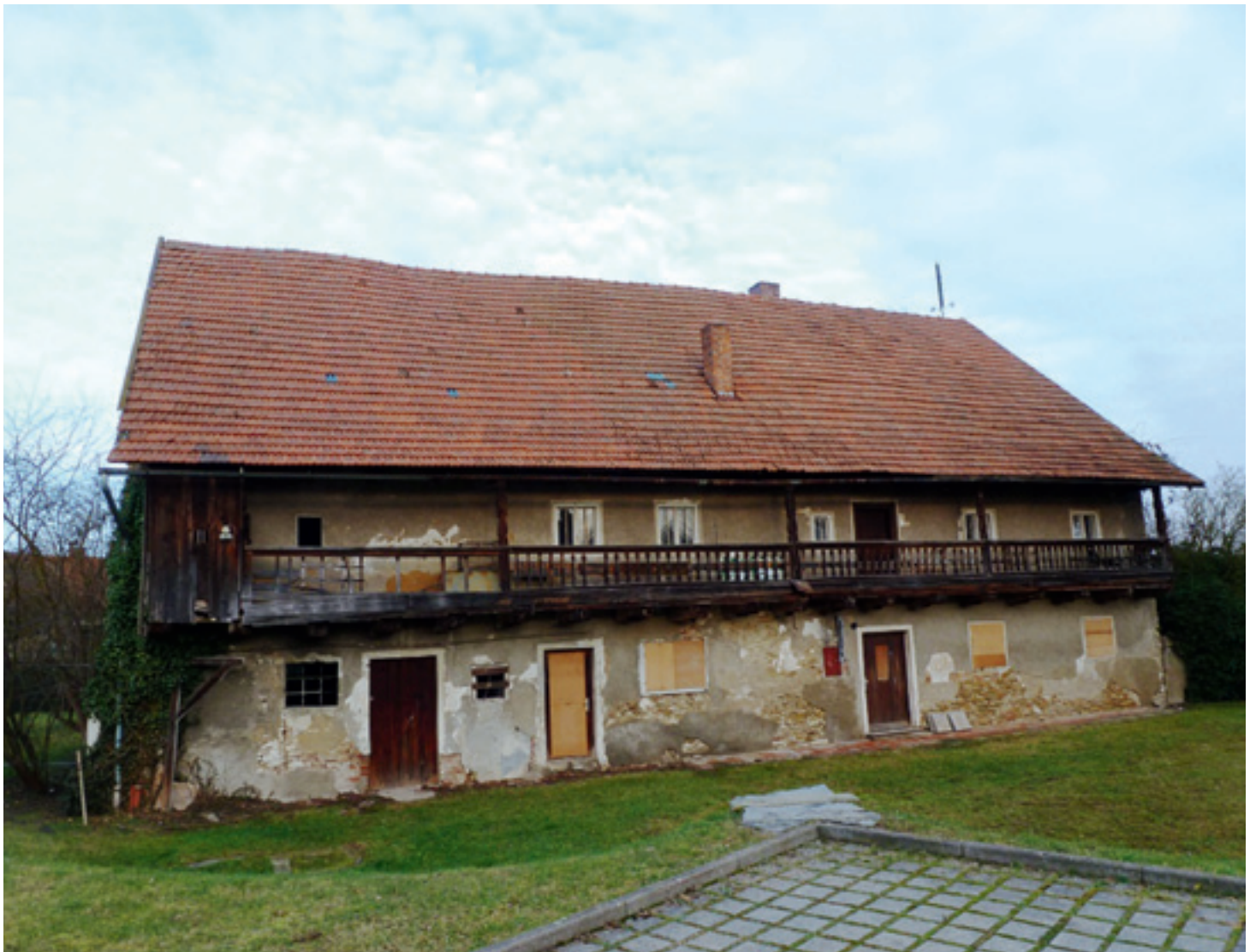
Abb. 1: Das Holzer-Haus in Mintraching vor seiner Sanierung
