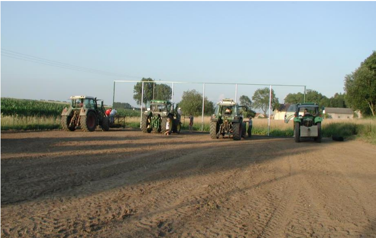
Arbeiten am neuen Bolzplatz Wolkering 2007
