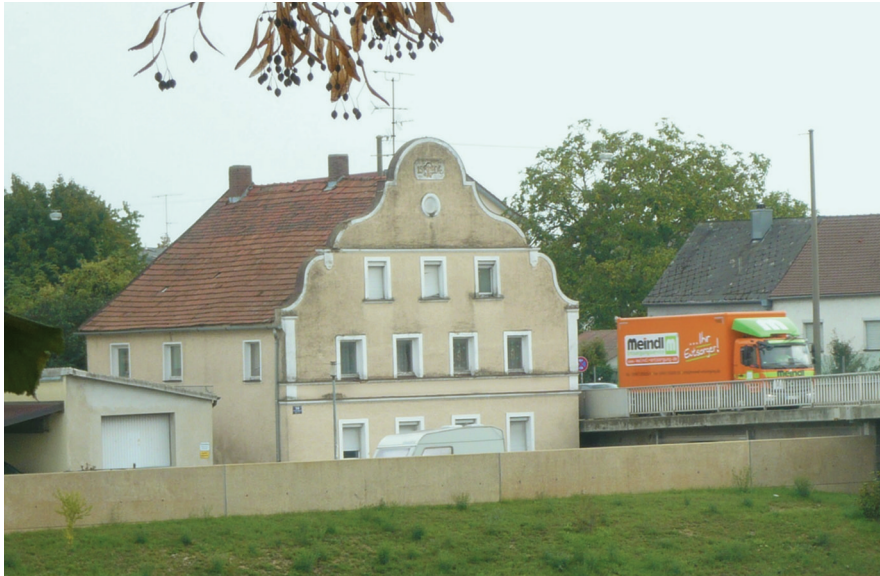
Abb. 5: Foto: Reinhausener Damm 14, M. Fritsch, 2018.
