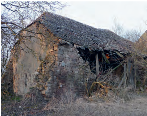
Abb. 42: Ruinen der Wirtschaftsgebäude von Steinrinnen 5 und 6 (Aufnahme: 02/2018)
