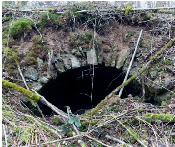
Abb. 10: Felsenkeller südlich der Straße zwischen Eichelmühle 2 und 3 (Aufnahme: 03/2019)
