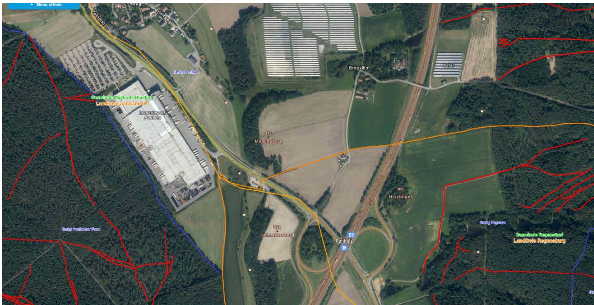
Abb. 46: R X Industriepark Ponholz Netto Luft Bayerische Vermessungsverwaltung Nr. 2306-9190
