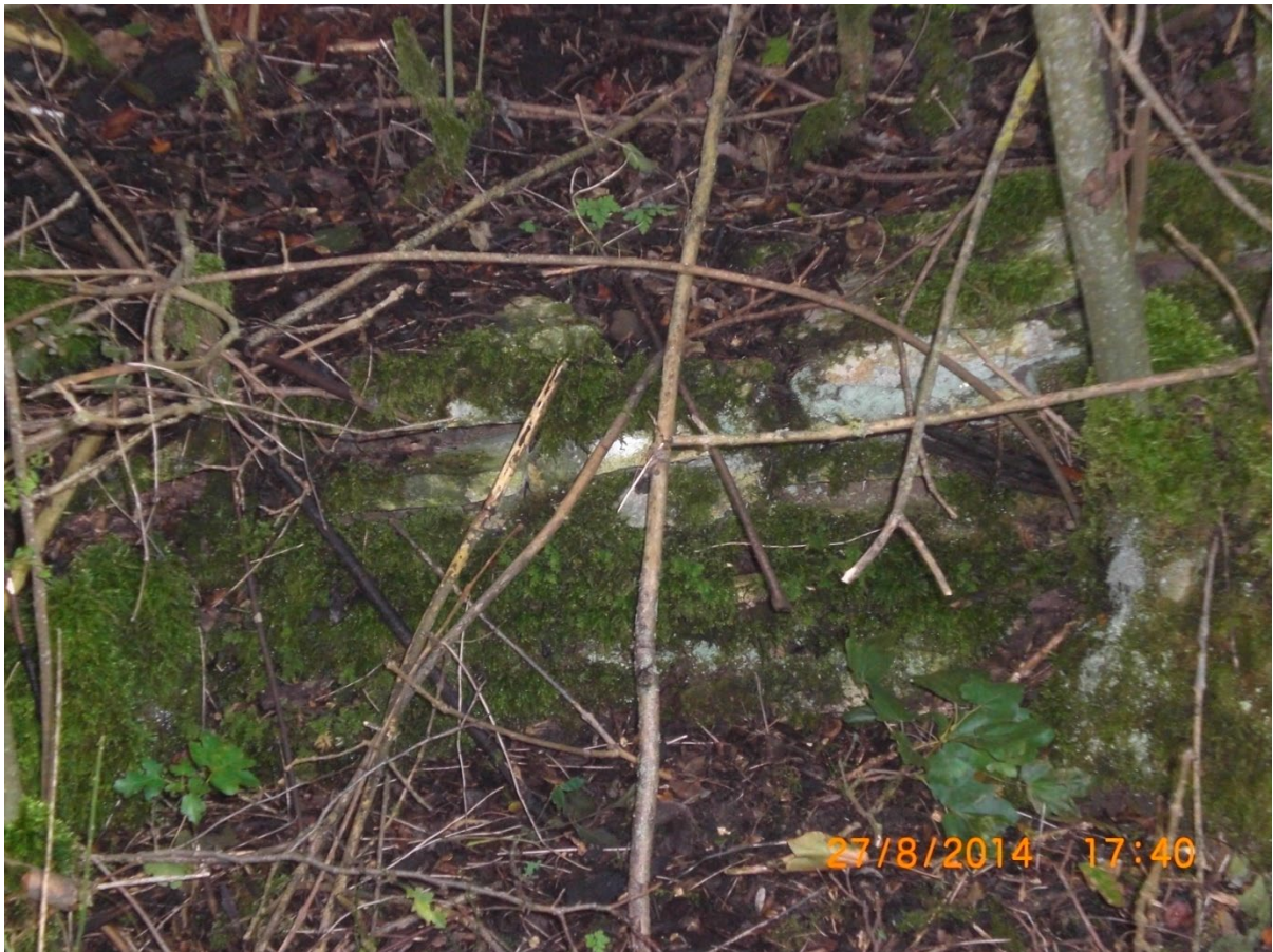
Abb. 15 Premberg-Emhof: Saaß: Beidseitig des Hohlweges sind Steinwände. Diese sind vollständig zugewachsen 4501954 5454912
