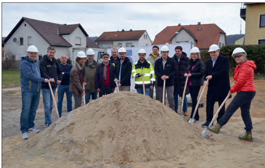
Abb. 2: Spatenstich zum Rathausneubau
