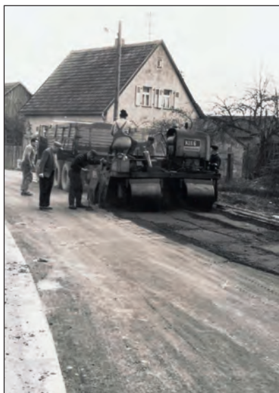
Abb. 19: Asphaltierungsarbeiten beim Haus Ringstraße 41
