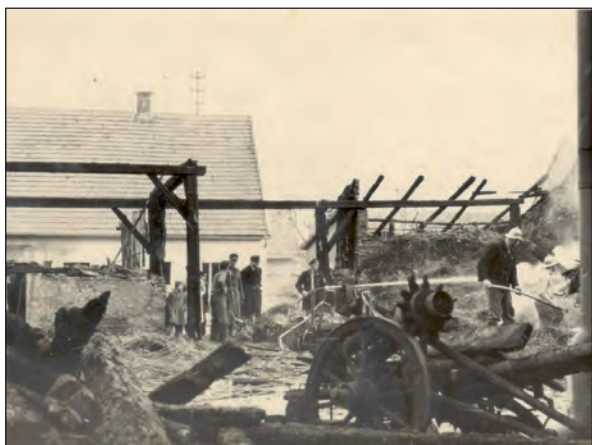
Abb. 41: Scheunenbrand in der Kirchstraße
