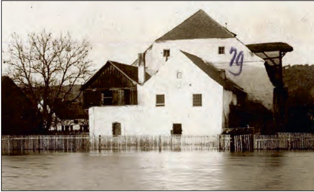
Abb. 14: Brauereigebäude von Süden bei Hochwasser von 1920
