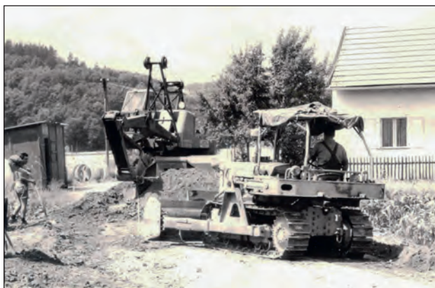
Abb. 20: Abtragung der Schichten beim Haus Tegernheimer Kellerstraße 16
