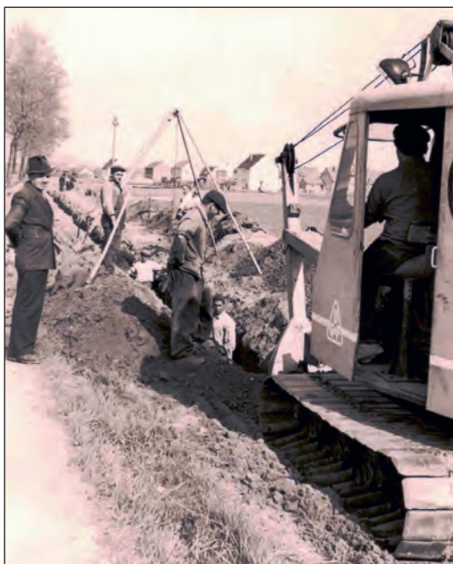
Abb. 17: Wasserleitungsbau in der Hauptstraße
