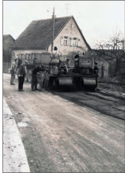
Abb. 19: Asphaltierungsarbeiten beim Haus Ringstraße 41
