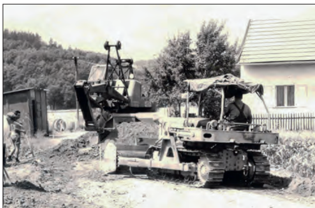
Abb. 20: Abtragung der Schichten beim Haus Tegernheimer Kellerstraße 16
