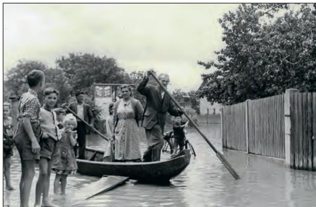
Abb. 36: Hochwasser 1954: Kirchstraße 1 bei Metzgerei Schiller (heute Metzgerei Muggenthaler)
