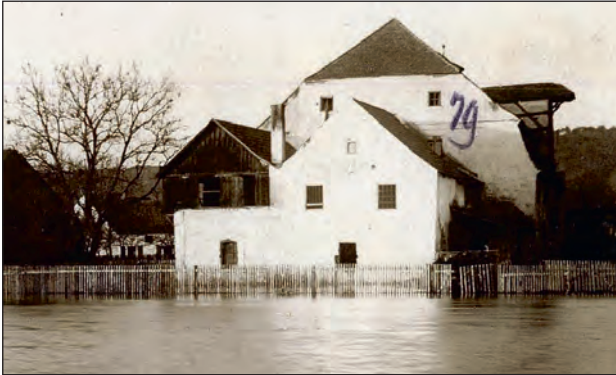
Abb. 14: Brauereigebäude von Süden bei Hochwasser von 1920
