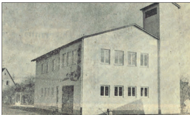
Abb. 9: Das neue Rathaus mit Feuerweh- gerätehaus
