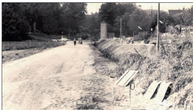
Abb. 22: Vorbereitungen zu den Asphaltie- rungsarbeiten beim Tegernheimer Keller
