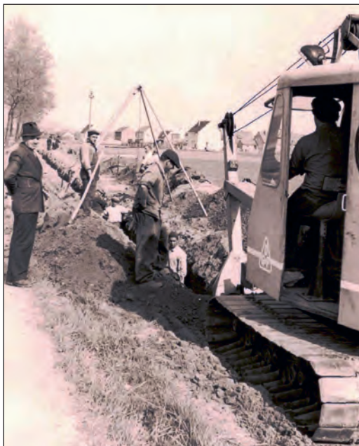
Abb. 17: Wasserleitungsbau in der Hauptstraße
