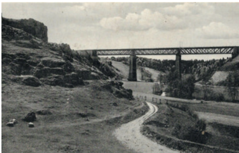
Abb. 3: Die Eisenbahnbrücke überspannt das Tal der Schwarzen Laber.
