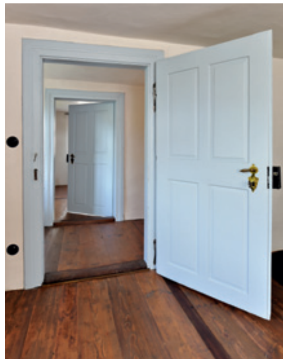
Abb. 8: Zur bauzeitlichen Innenausstattung gehören u. a. die Innentüren und die Holzfußböden.
