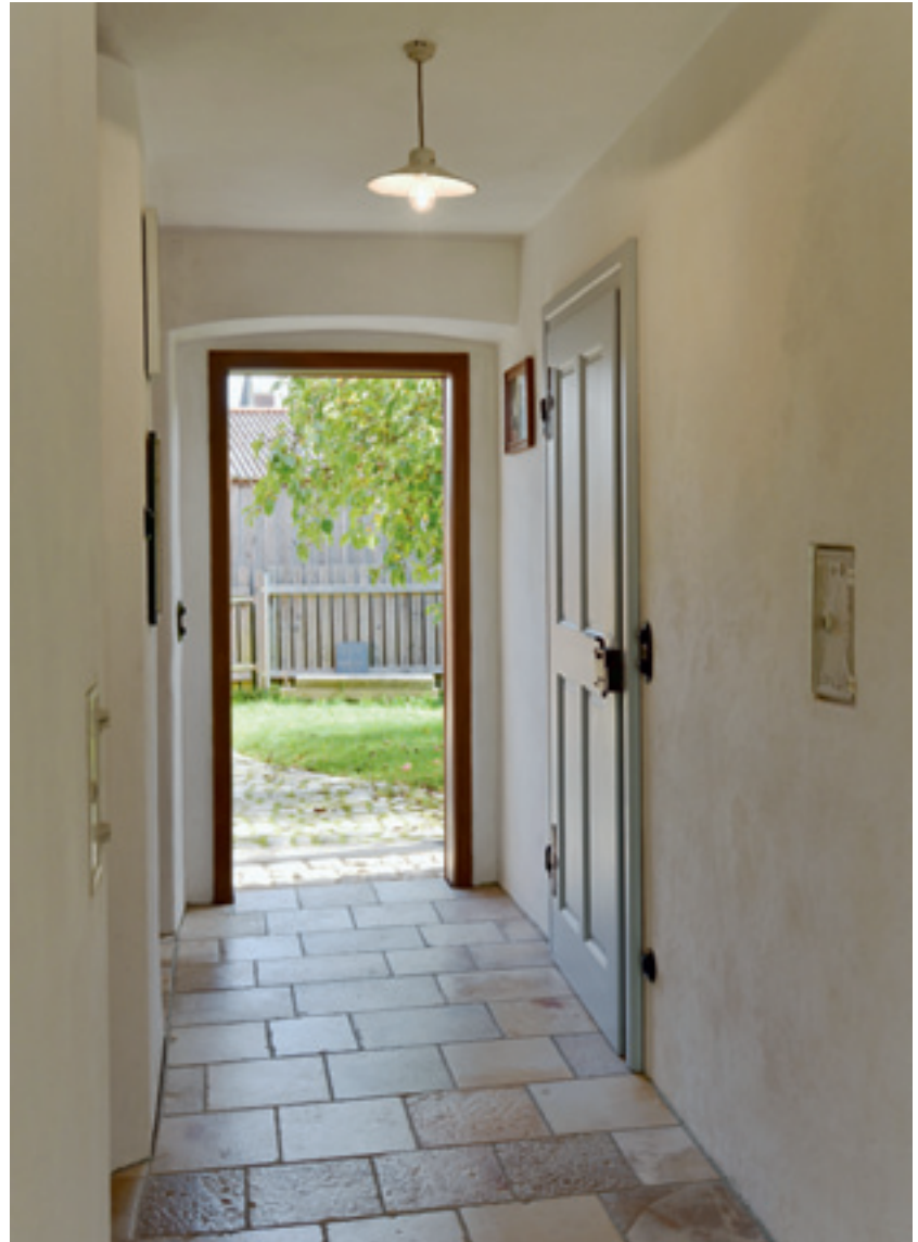
Abb. 9: Das Neckerhaus wurde zwischen 2015 und 2018 umfassend und doch behutsam instandgesetzt.
