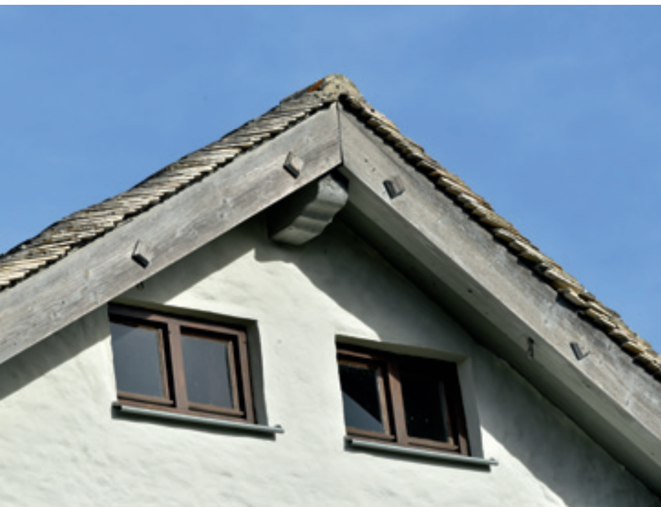
Abb. 7: Der Dachstuhl wurde ertüchtigt und das originale Legschieferdach aus dem 19. Jahrhundert saniert.
