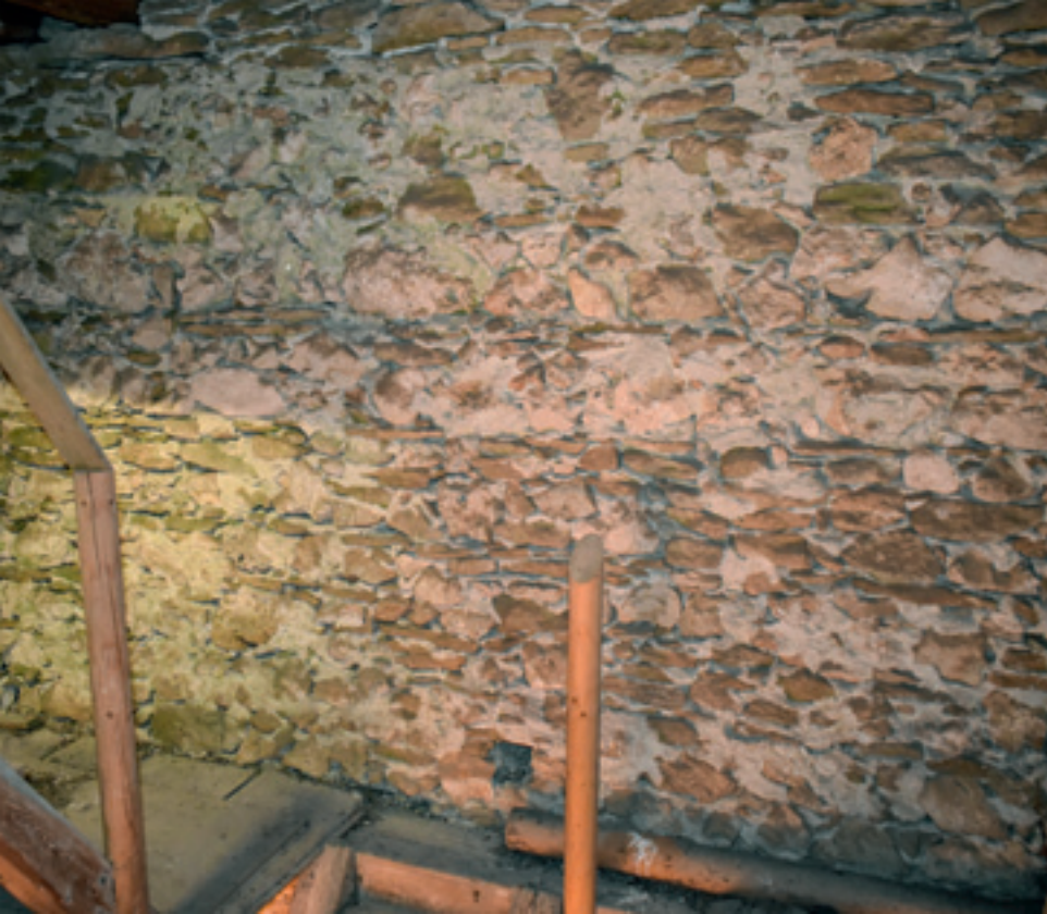
Abb. 14: Ostmauer in Turmgeschoss 3: Gut zu sehen sind die immer wieder durchschießenden Lagen aus plattigen Steinen.
