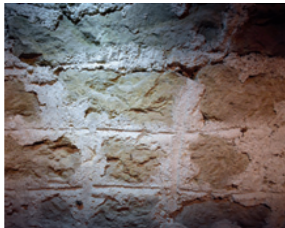
Abb. 13: Das pietra rasa- Mauerwerk: Detail- aufnahme der Maueroberfläche an der Ostmauer in Turmgeschoss 1
