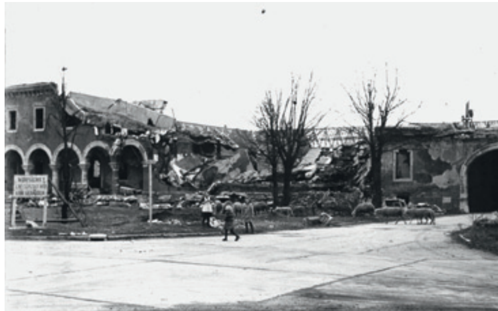
Abb. 2: Ruine der ehemaligen Kommandantur des Fliegerhorstes, an der Haupt- einfahrt der Vertriebenensiedlung gelegen, um 1950
