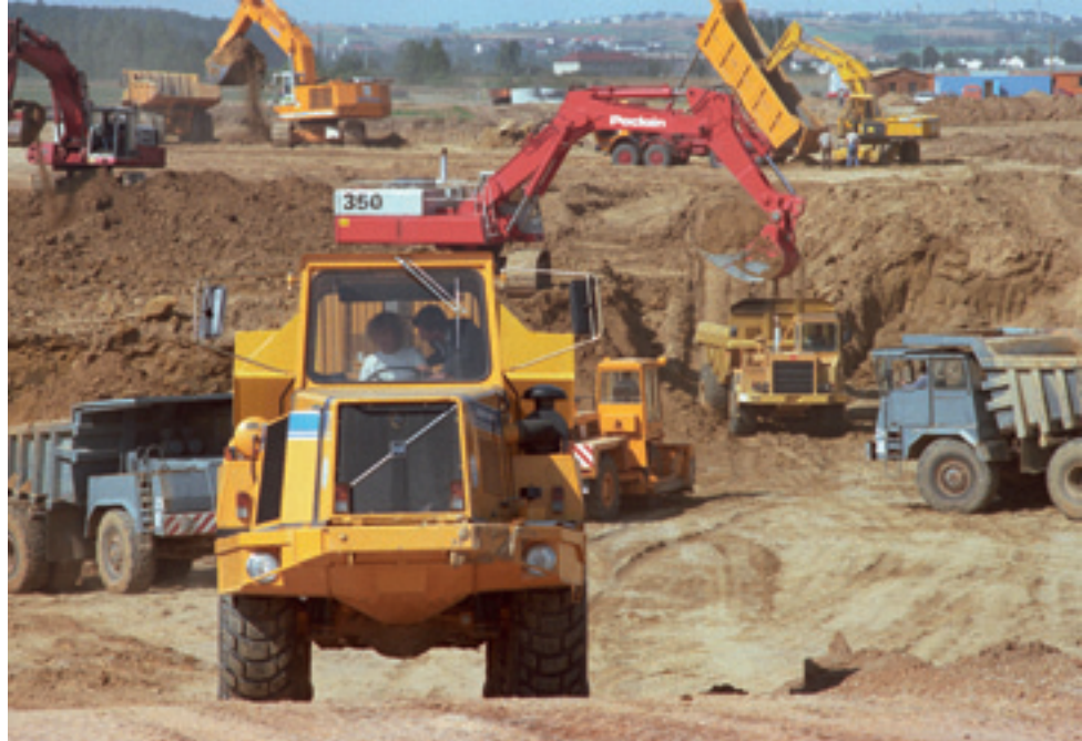
Abb. 4: Das Ausmaß der Erdarbeiten beim Bodenaustausch war enorm.
