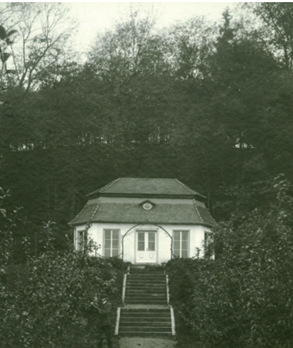
Abb. 8: Das erhöht gelegene Teehaus mit Walmdach, um 1900
