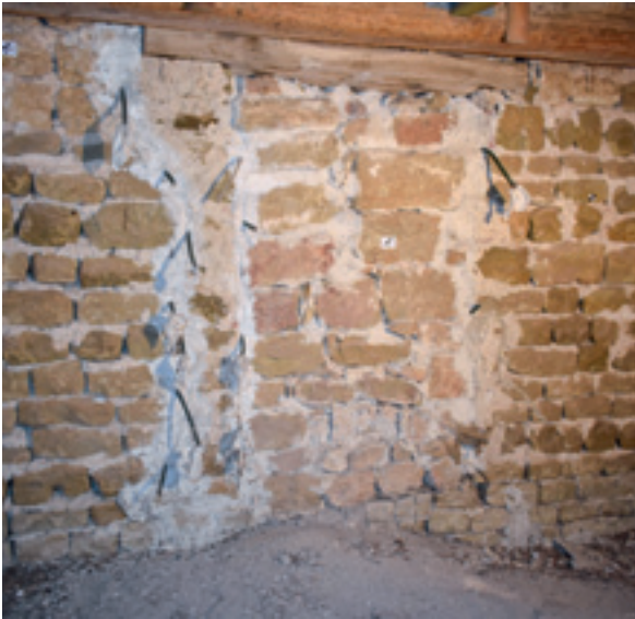
Abb. 11: Zugesetzte Maueröffnung im 1. Turmgeschoss, von Osten aus fotografiert
