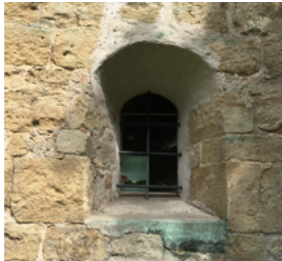
Abb. 7: Die Südfassade mit den beiden kleinen romanischen Fenstern, dem größeren barocken Fenster und dem zugemauerten Hocheingang
