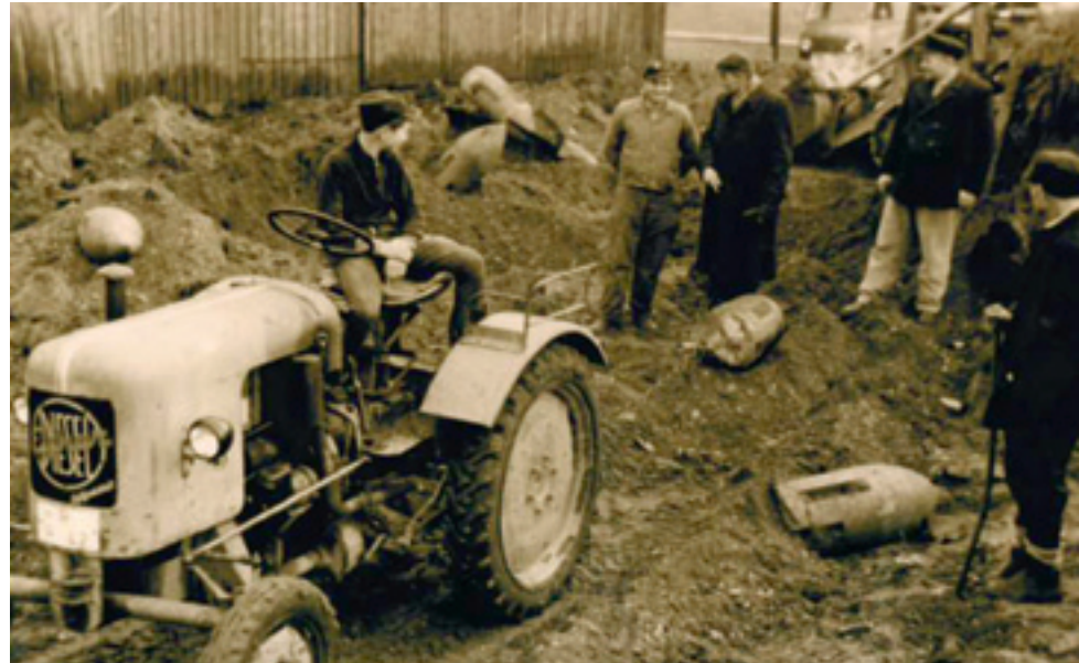
Abb. 10: Improvisierte Beseitigung von Bombenmaterial im jetzigen Ortsteil Birkenfeld, um 1950
