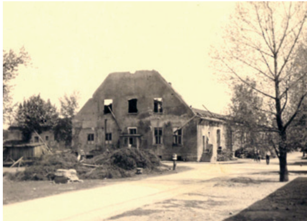
Abb. 7: Ruine eines Wirtschaftsgebäudes am Fliegerhorst Obertraubling, ca. 1948 Es wurde zunächst als Unterkunft für mehrere Landwirtschaftsfamilien samt Viehbestand genutzt und 1952/1953 dann zu einer Volksschule ausgebaut.
