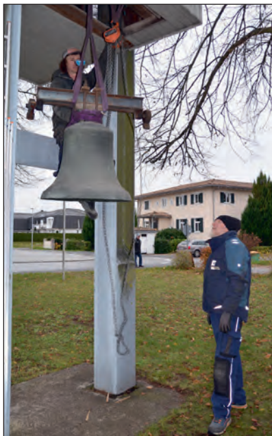
Abb. 6: Glockenabnahme
