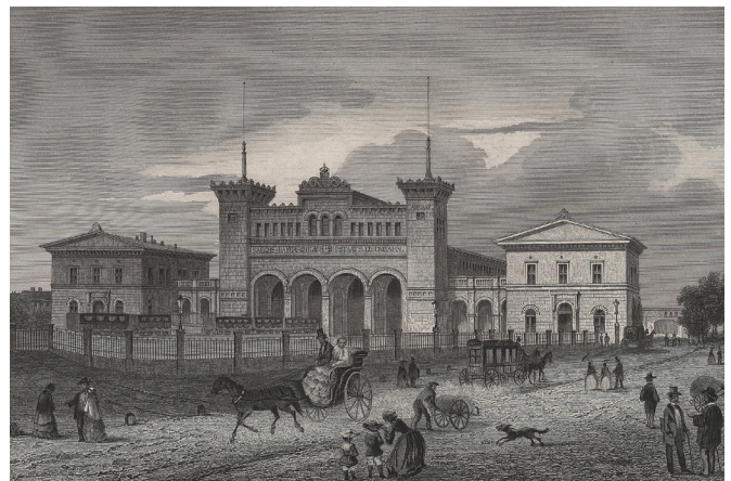
Der Sächsisch-Bayerische Bahnhof in Leipzig, erbaut 1844 (L. Rohbock – Joh. Poppel)
